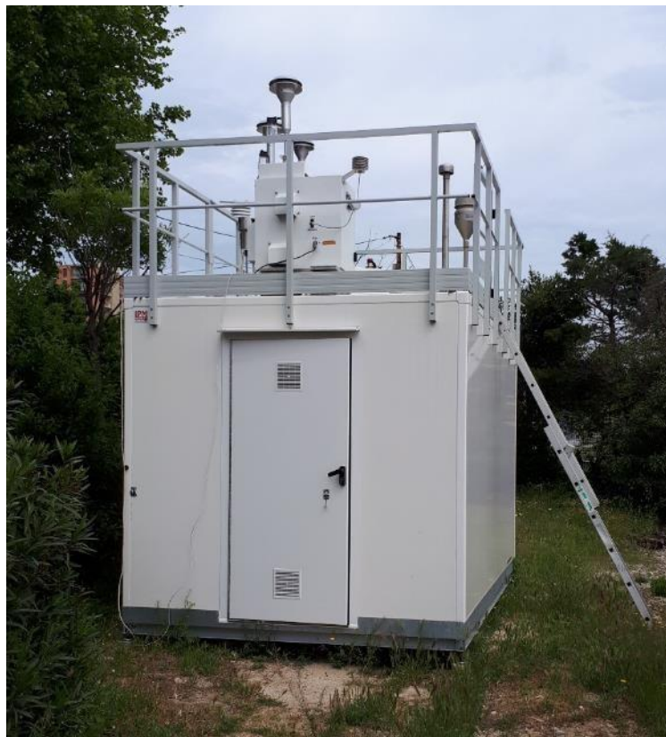
Figure 17 : Port de Bouc – La Lèque – site référence AtmoSud, Rue de la République, Port de Bouc
